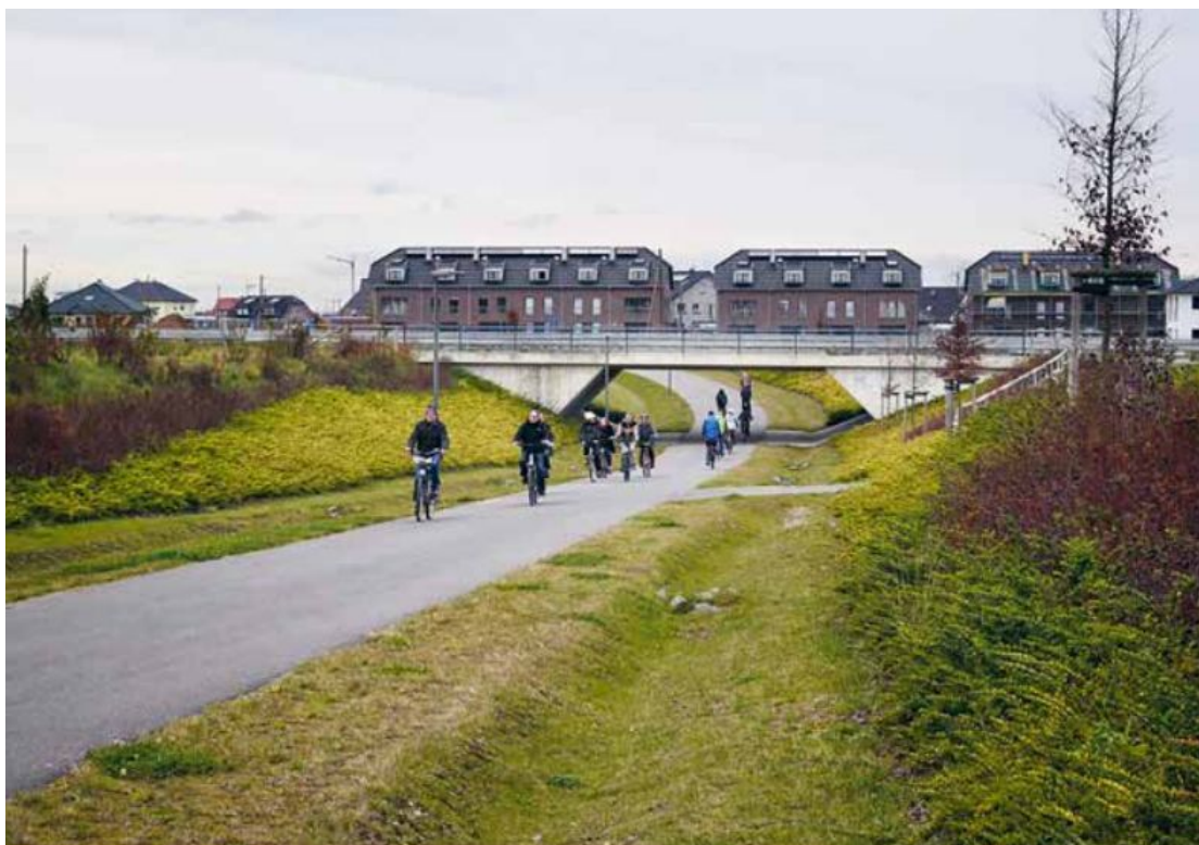
Abbildung 41: Einsehbarkeit Unterführung K 17 Kerpen-Manheim-neu aus Osten (Bild: Kolpingstadt Kerpen)
