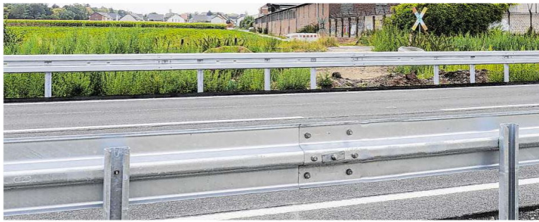
Dass die B56n einen Wirtschaftsweg trennt, der von vielen Radfahrern zwischen Düren und Girkelsrath genutzt wurde, kritisieren Leser. FOTO: SISTEMICH
